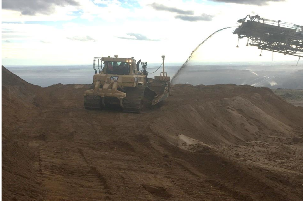
Abbildung 42. 1.Phase. Planieren von 1. Körper
