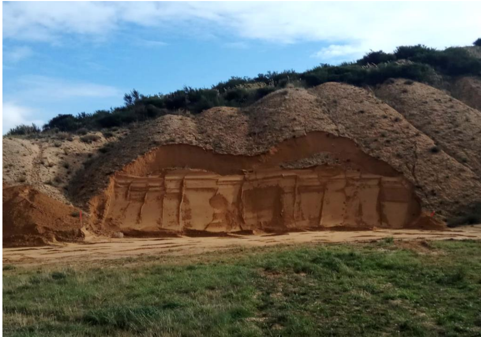
Abbildung 51. Steilkante in der bestehenden Böschung. Standort 3
