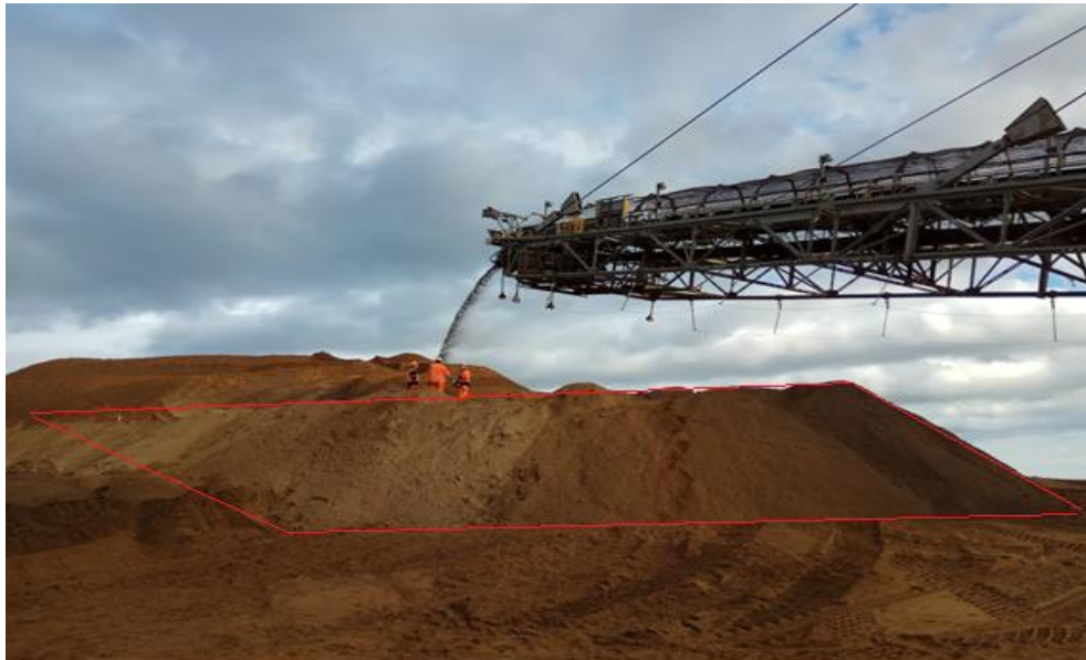
Abbildung44. Der 1. Körper nach dem Planieren und Verdichten mit Rampe
