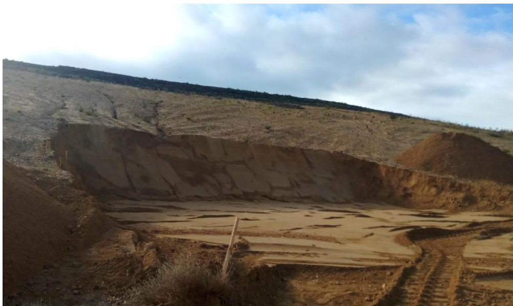
Abbildung 49. Steilkante in der bestehenden Böschung. Standort
