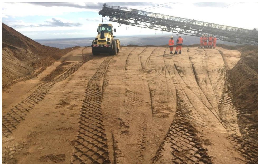
Abbildung 43. 1. Phase. Verdichten von 1. Körper
