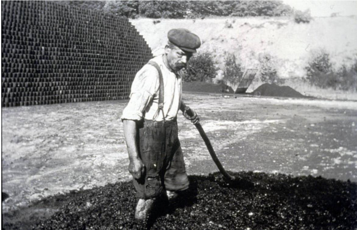
Abbildung 5: Stampfen bei der Klüttenherstellung
