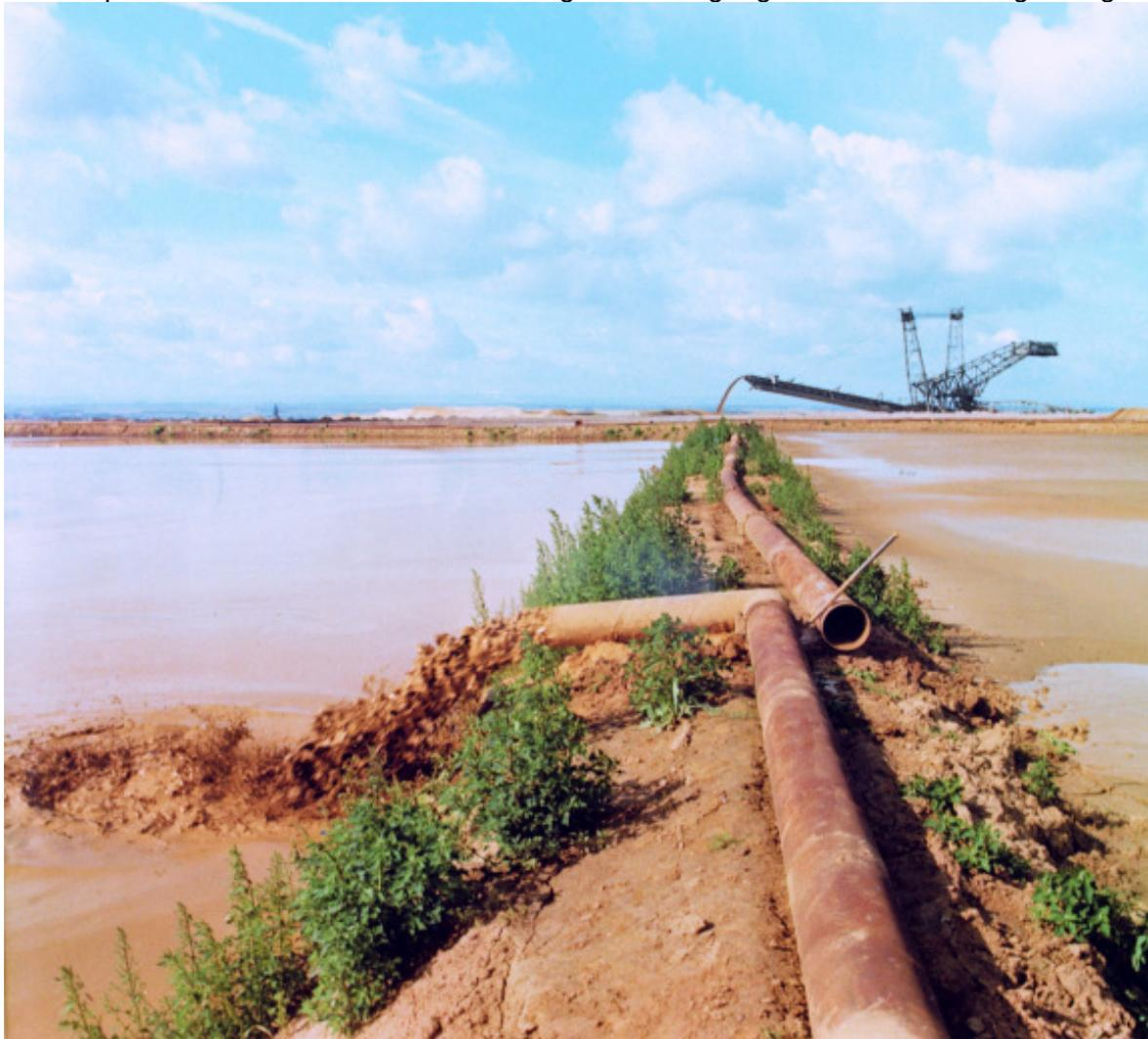
Abbildung 9: Früher angewandtes Spülverfahren zum Lössauftrag.
