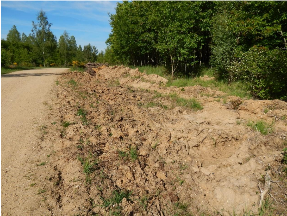
Anhang 25. Schaffen von offenen Bodenbereichen Foto: Marius Schneider
