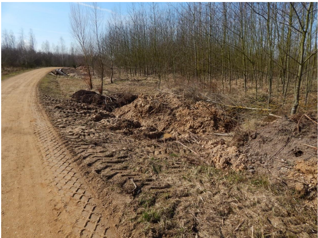
Anhang 28. Drainage um Staunässe zu verhindern Foto: Marius Schneider
