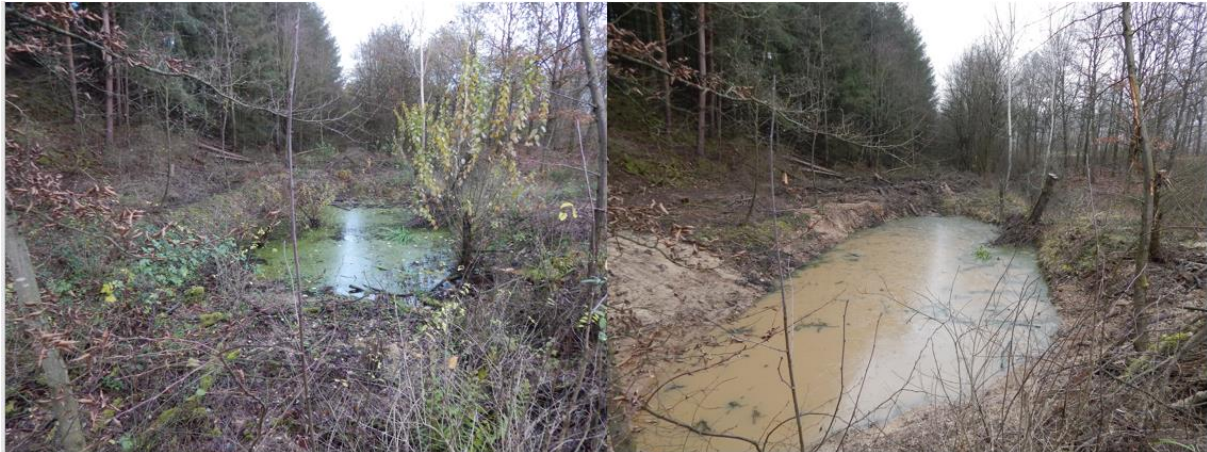
Abbildung 23: Gewässer 16 vor und nach dem Verbreitern des Gewässers und dem Freistellen, am 04.12.2021 und 15.01.2021
