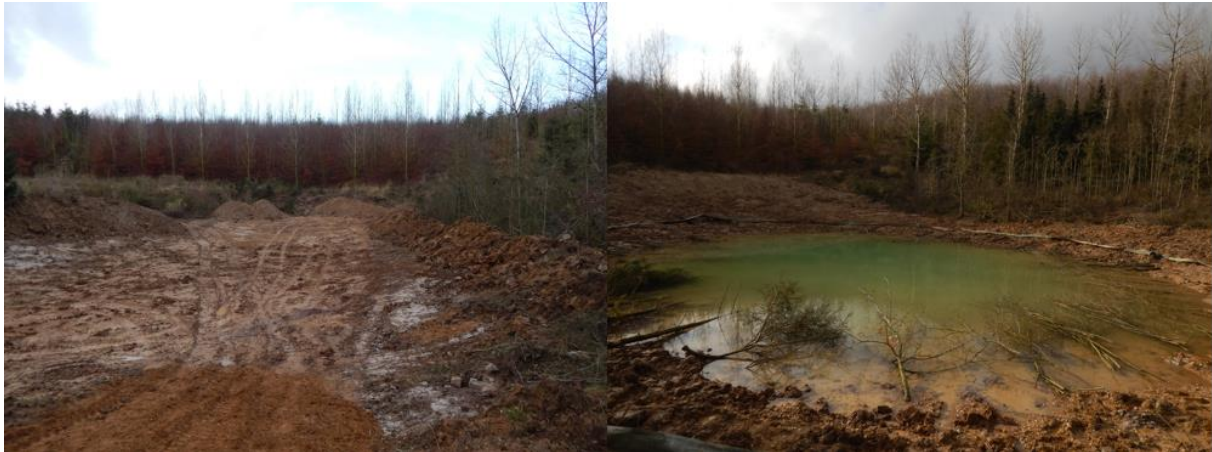
Abbildung 6: Ergebnis der Tonabdichtung und dem Einbringen von Totholz zur Schaffung von Strukturvielfalt zwischen dem 04.12.2020 und dem 03.02.2021, in Gewässer 22
