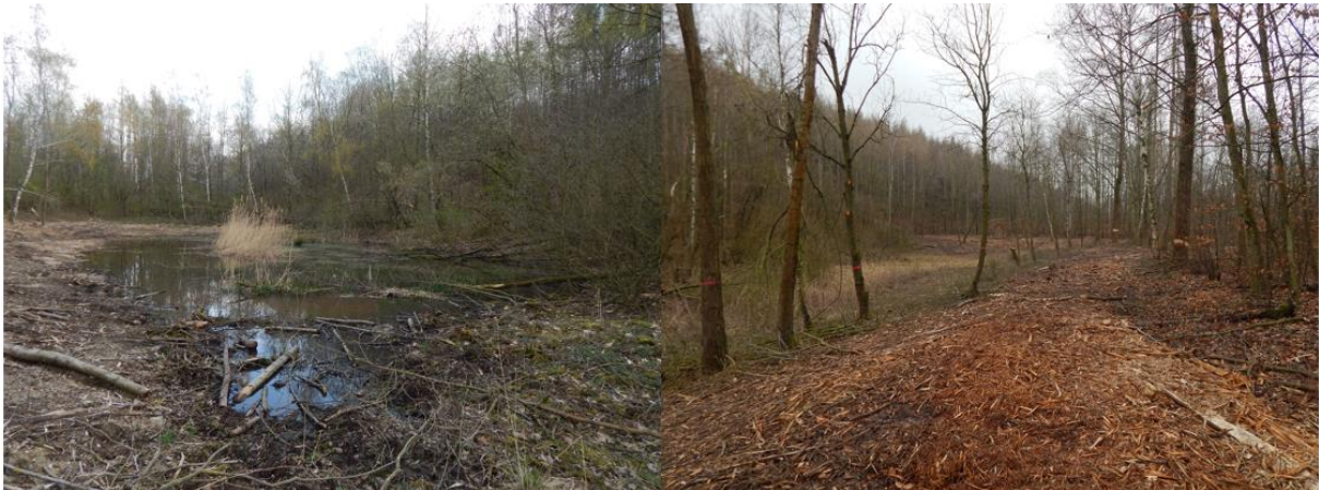
Abbildung 20: Gewässer 13 dauerhaft wasserführend und trockener Gewässerabschnitt nach dem freistellen, am 14.03.2021 und 15.01.2021
