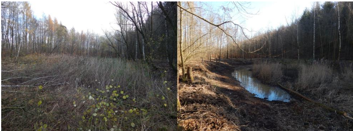
Abbildung 7: Ergebnis des Entfernens von Röhricht im und aufwachsender Vegetation um Gewässer 12 zwischen dem 04.12.2020 und dem 21.02.2021
