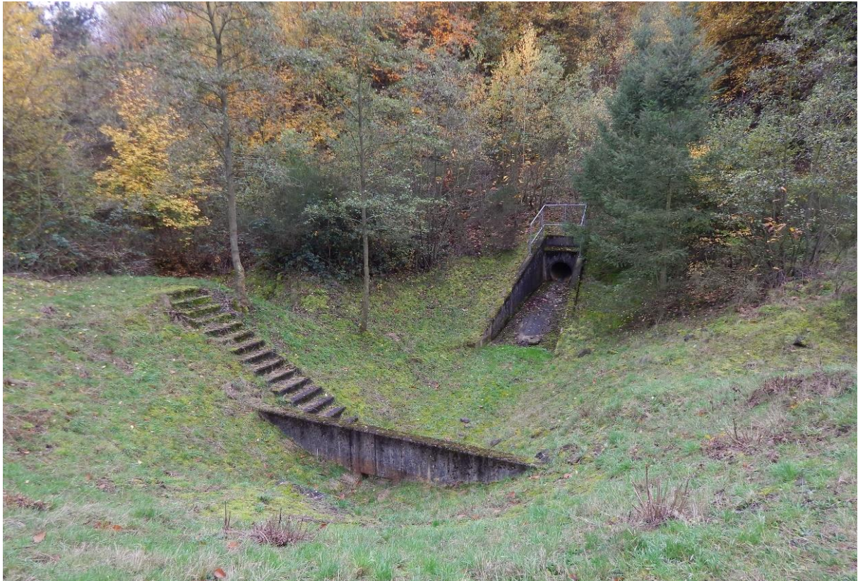
Anhang 5: Schussrinne mit Sammelbecken auf der zweiten Berme, am 13.11.2021
